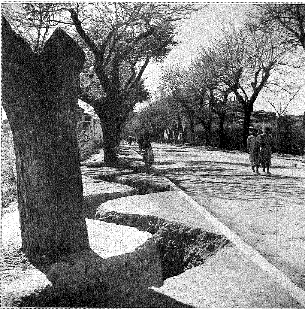
A la sortie de Huesca : tranchée creusée par les nationalistes dans le trottoir de la route de Barbastro.
